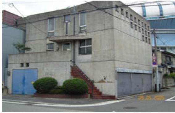
築後20年久、水泥部分已劣化了、鐵門上的水泥一上水、水就浸透進去的状态
