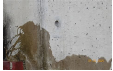
築後20年久、水泥部分已劣化了、鐵門上的水泥一上水、水就浸透進去的状态
