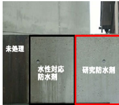
防水處理3日後、撥水5分後的狀況。
